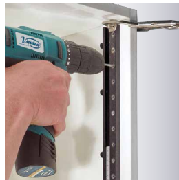
Сверление отверстий для установки полок
